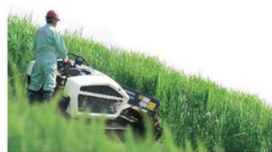
写真 1.9 堤防法面での除草作業状況(法尻から法肩への)| 223
