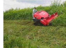
写真 1.9 堤防法面での除草作業状況(法尻から法肩への)| 223
