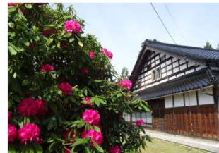
富山県南砺市の切妻屋根の「アズマ立ち」の家
