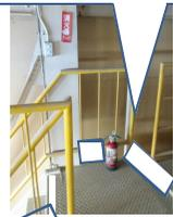
階段の降りがけに段を識別できる様、滑り止め白色テープ(3M すべり止めテープ タイプA 幅25mm)を張ると、踏み外し転落のリスクは低下する
