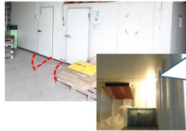
① 冷蔵庫内に照明は点灯し、閉じ込め時の脱出装置もありました。(動作確認はしていません) 施設の全員に脱出装置の操作方法、閉じ込め防止の手順をドアに掲示し周知してください
